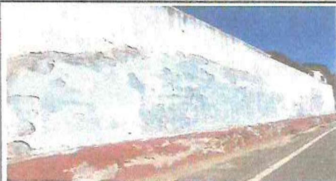
Foto 1: Reparación de muro perimetral deteriorado con una inclinación fuera de lo normal. Vista de Sur hacia Norte.
